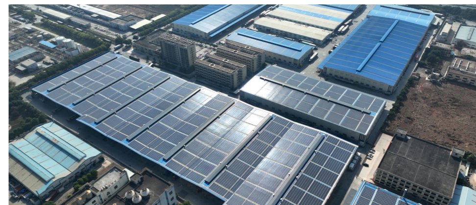
佛塑科技光伏发电
